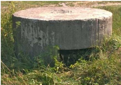
Железобетонный бронезащитный элемент марки "Колпак" Р-0.7М пулеметной огневой точки. Расположен южнее Варшавского шоссе не доходя до урочища Большая Шубинка в траншее на берегу реки Выпрейка.
