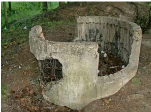
Железобетонный бронезащитный элемент марки "Колпак" Р-0.7М пулеметной огневой точки. Расположен южнее Варшавского шоссе за молочной фермой в траншее на берегу реки Выпрейка.
