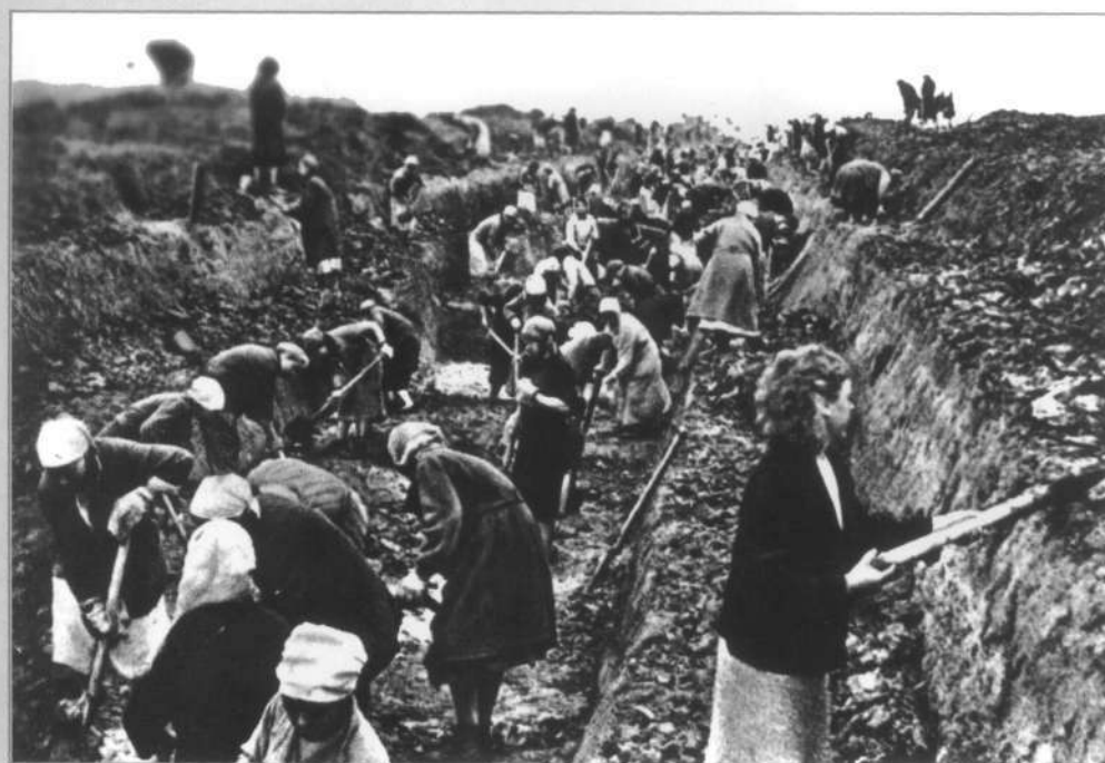
На строительстве оборонительных укреплений Можайской линии обороны
